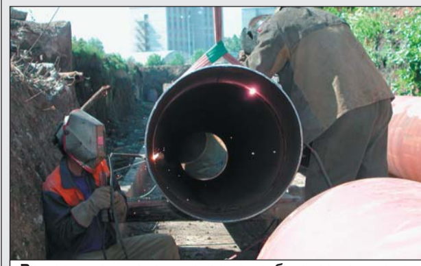
Во время отключения старые трубы отремонтируют
