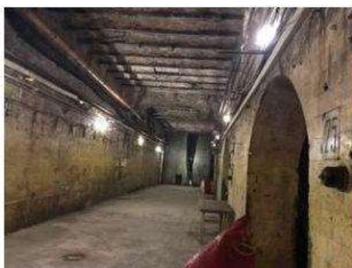
Аналогичная ситуация в коридоре, соединяющем ледники с погребями. Наблюдается не нарушенная регулярность сводов Монье и арочных проходов.
