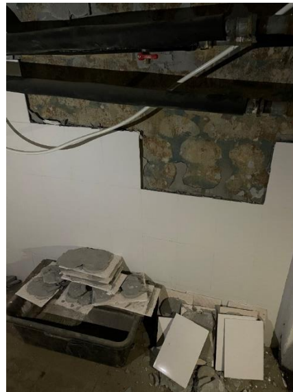
Некачественный монтаж керамической плитки
