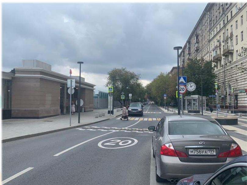
Установка ИДН у станции метро Студенческая
