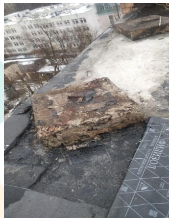
Невосстановленные монтажные блоки ограждений
