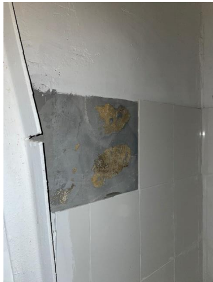
Некачественный монтаж керамической плитки
