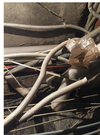
Не демонтированное электрооборудование и проводка
