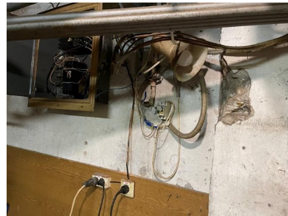
Не демонтированное электрооборудование и проводка
